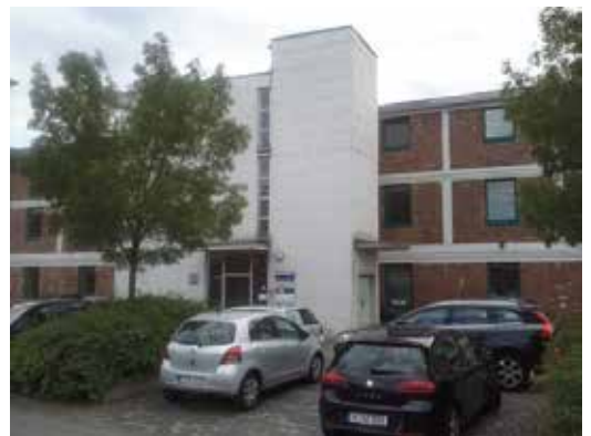
Bild 2: Eingang zum Treppenhaus (2. OG)
